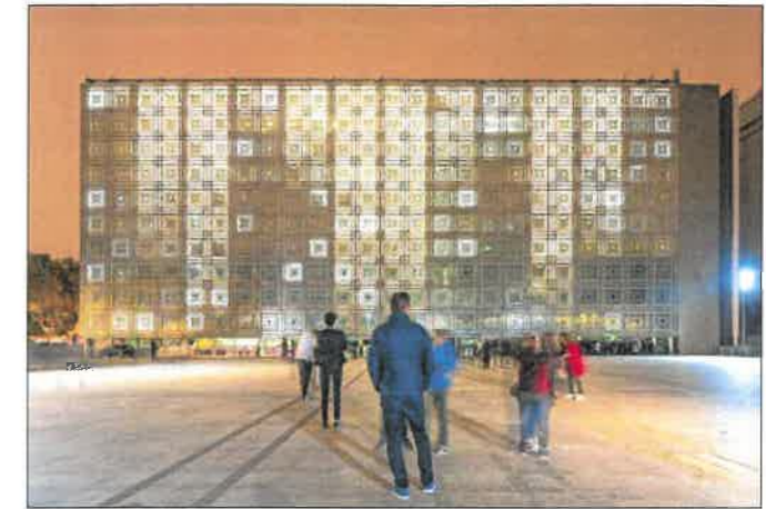
De zonnepanelen van het Institut du Monde Arabe in Parijs is gebaseerd op de iris van een oog. Toch is het systeem niet onfeilbaar. © Image Select
